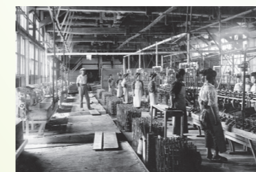
米沢工場の紡糸室
